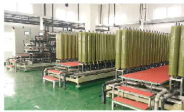
上海老港项目现场
